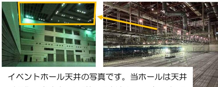
イベントホール天井の写真です。当ホールは天井耐震化工事や床、照明等の更新を行う予定です。足場を組立てて、天井や設備機器を解体した状況です。今後さらに足場を組み上げて天井内の耐震化及び設備機器更新工事を行います。
